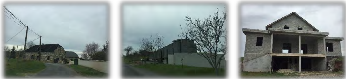
Photographie 25 : Bâti présents sur la Pouyge
