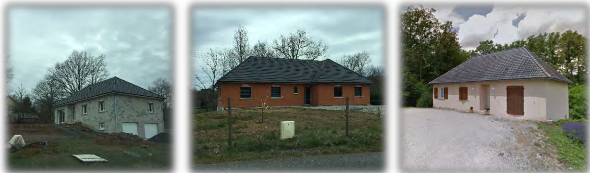
Photographie 32 : Bâtis présents sur le Chambon et Bayat
