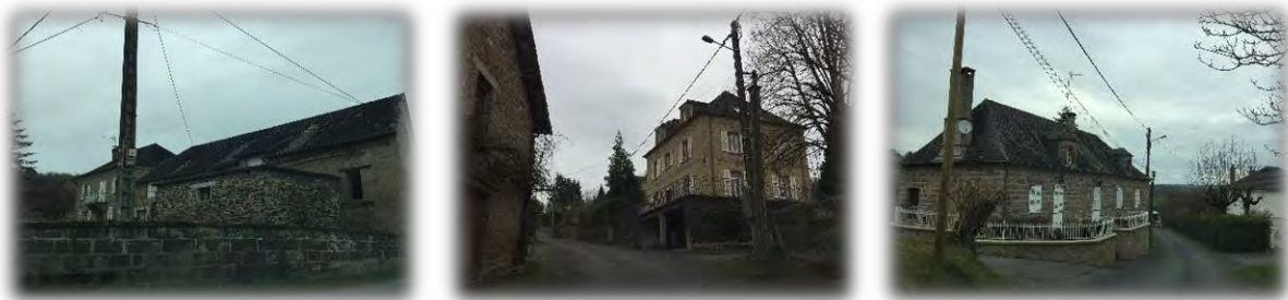
Photographie 27 : Bâti présents sur le Four
